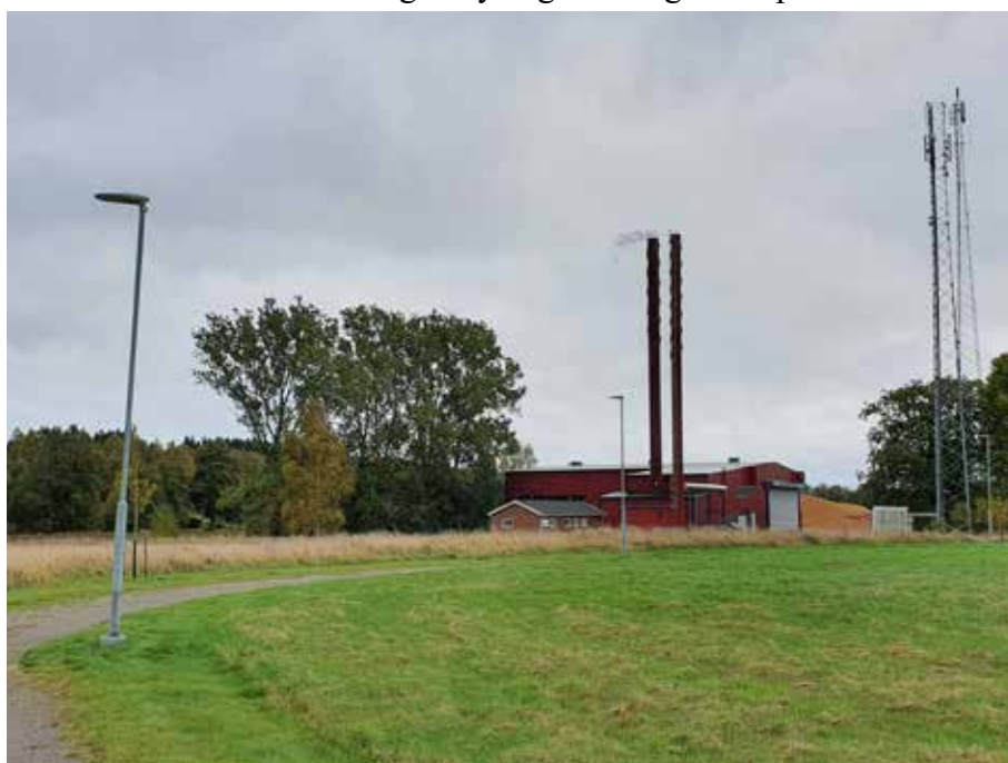
Värmeverket ligger idag mitt i rekreationsområdet Stallaholm.
