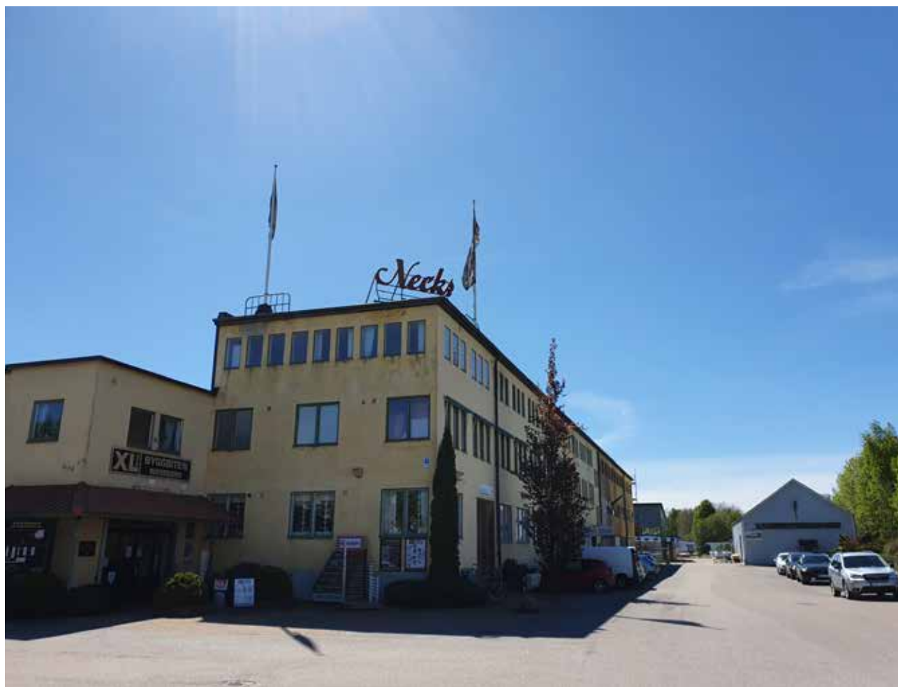
Industribyggnaderna vid Necks industriområde har kulturhistoriska värden.
