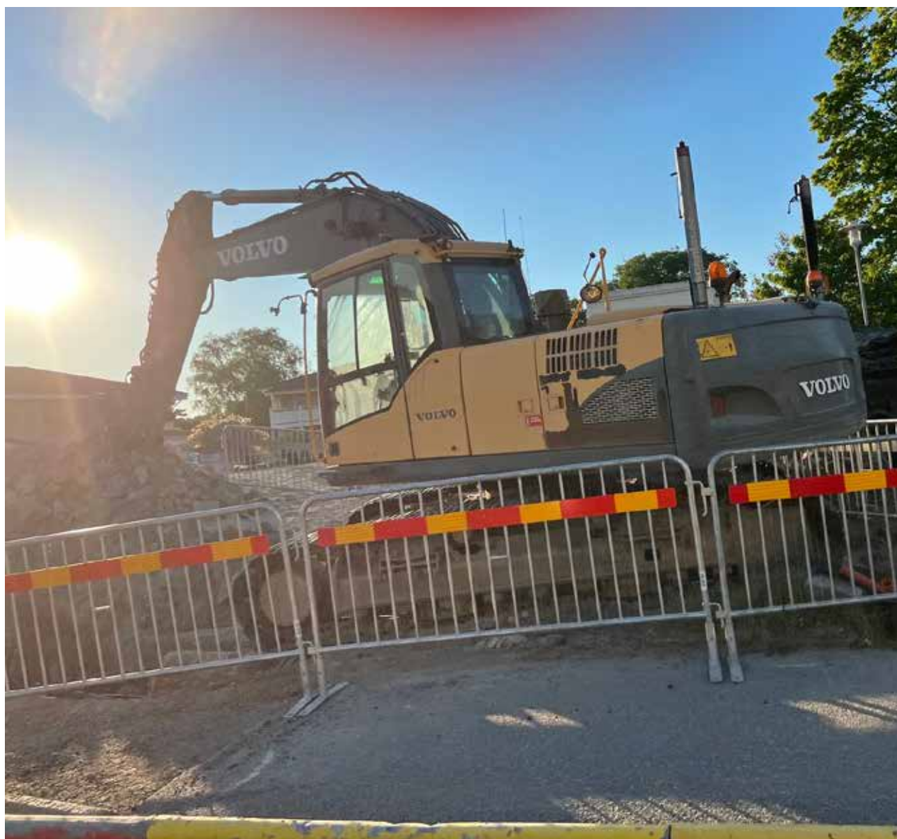
Arbete pågår i Nossebro! Inriktningar och rekommendationer gäller från planering till byggande och förvaltning.
