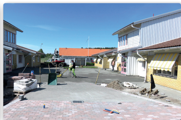
Pågående arbeten på utemiljön vid Gullviva och Mandelblom
