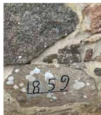
Husgrund vid kvarnbyggnaderna.
